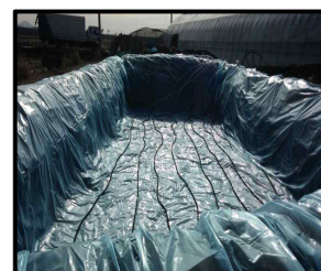
그림 8. 저압분산고무질호스(유니바이오토크스) 설치 모식도 및 설치방법
