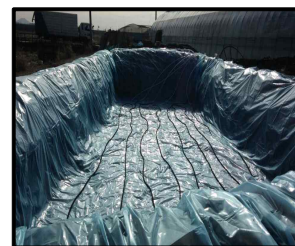
그림 8. 저압분산고무질호스(유니바이오토크스) 설치 모식도 및 설치방법
